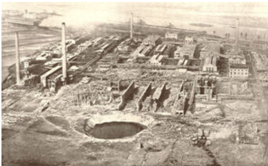
Zur Nacht des 21. Septembers mit der Explosion der Salpetermin Oppauer Werk der Badischen Anilin- und Sulfonwerke (B. A. S. W.). Die Überreste des Werks bei Sprengung des Ammoniumnitrat-Lagers. Länge des Kraters 125 m, Breite 90 m, Tiefe 20 m, Durchmesser des Kraters 125 m.
